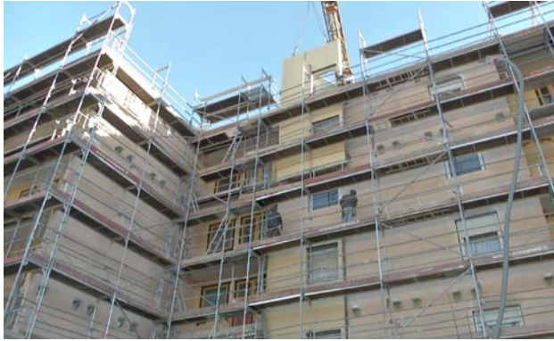
Fig. 7 SINFONIA project – panel installation (source: Benedikter Arkitekten)
