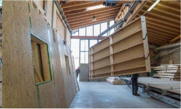
Fig. 8 SINFONIA project – panel production (source: Benedikter Arkitekten)
