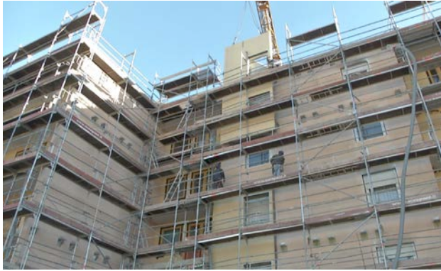
Fig. 7 SINFONIA project – panel installation (source: Benedikter Arkitekten)
