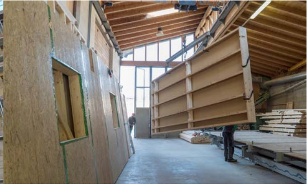
Fig. 8 SINFONIA project – panel production (source: Benedikter Arkitekten)
